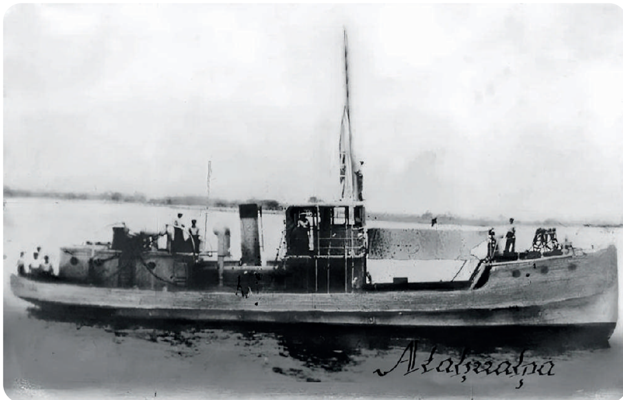
El vapor "Atahualpa" posteriormente aviso "Atahualpa" (1927-1960) Pequeño buque construido en los astilleros de Duran de 74 pies de eslora y 17 de manga, incorporado a la Armada del Ecuador en 1927 y participó durante la guerra con el Perú en 1941, derribando un avión enemigo.
