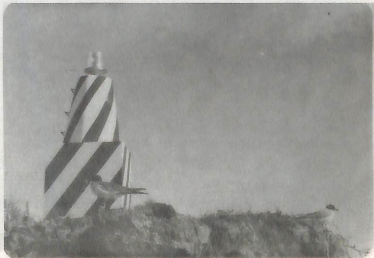
Vista del faro construido en la Isla Wolf (Galápagos).
