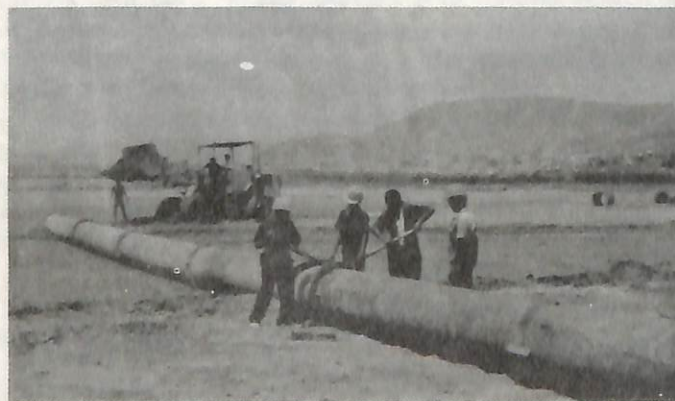
Personal en maniobra de tendido de tubería terrestre.
