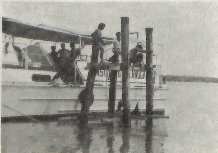
Construcción de la caseta para instalación de un Mareógrafo.
